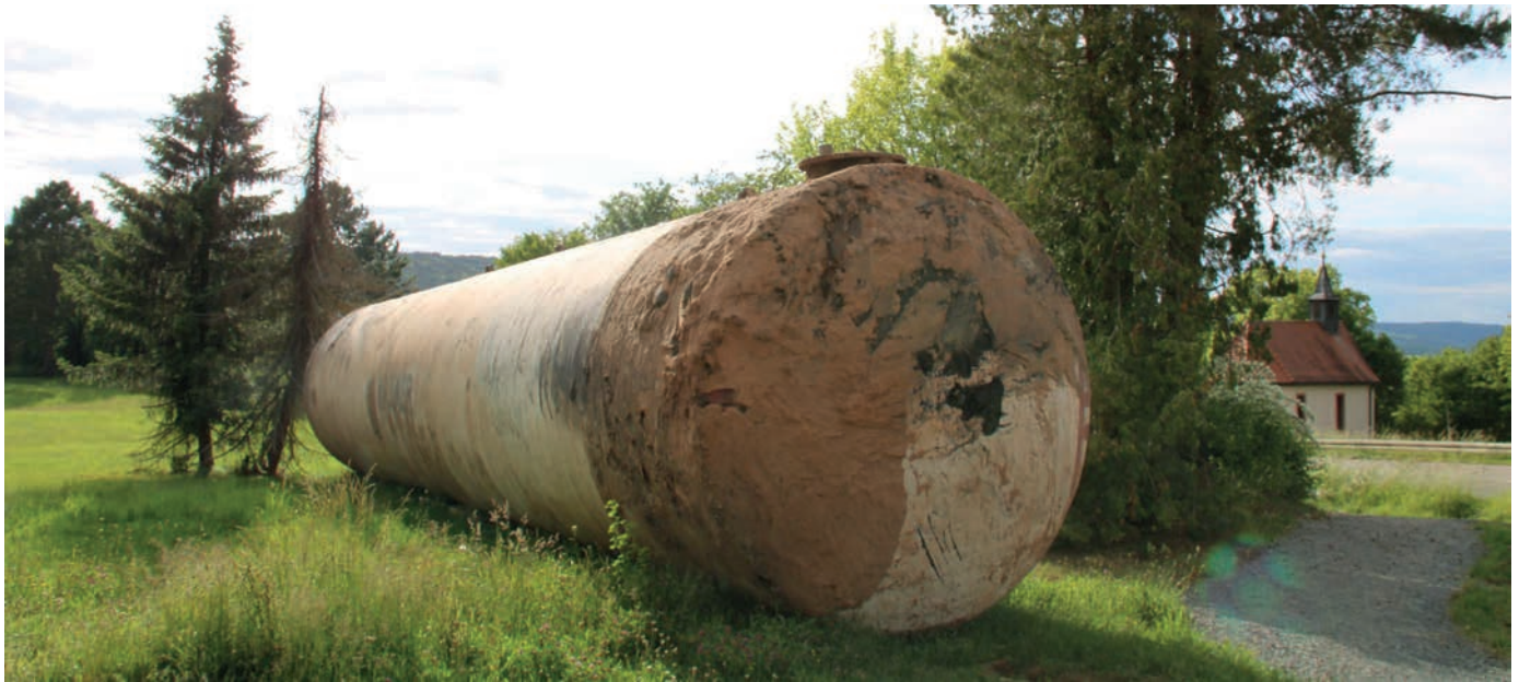
Erdlagertank: Der Heizöl-Erdlagertank mit einem Fassungsvermögen von 100.000 Litern wurde bereits demontiert.
